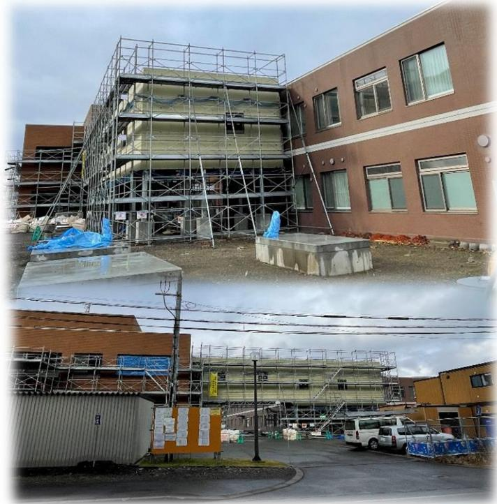
工事発注から6ヶ月程度経過し、現在の進捗状況につきましては建築主体工事では渡り廊下の外壁の角波張り、ヒルトップ玄関車寄せの軒天足場組立、躯体の改修では腰壁の解体、壁の間仕切り・床補修などが行われております。
